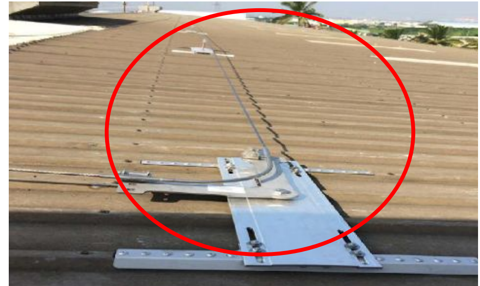
屋頂作業-鋼索材質水平防墜式統
