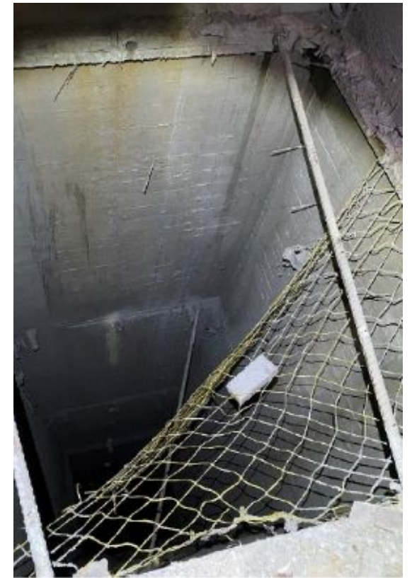
電梯井內剩2 根支承工作平台之鋼筋及殘留2 邊之安全網，另有1 根鋼筋掉落卡在14 樓與15 樓間。
