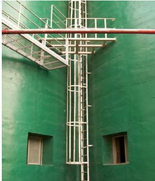
護籠爬梯(2 m以上) 設置垂直母索示意圖
