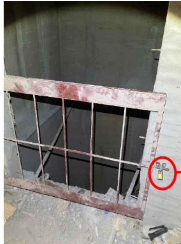
罹災者作業之 15 樓垃圾管道電梯井，未設置警告標示罹災者作業之 15 樓垃圾管道電梯井，未設置警告標示、未上鎖。
