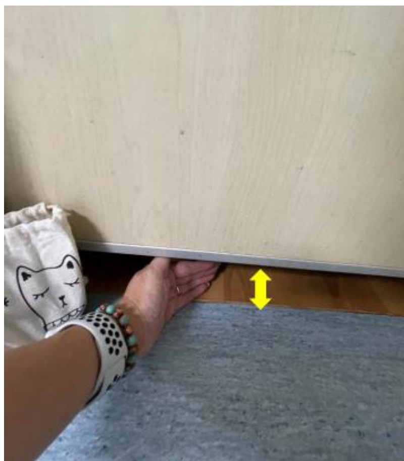
圖 20. D 棟病室門下方縫隙過大(黃色箭頭)
