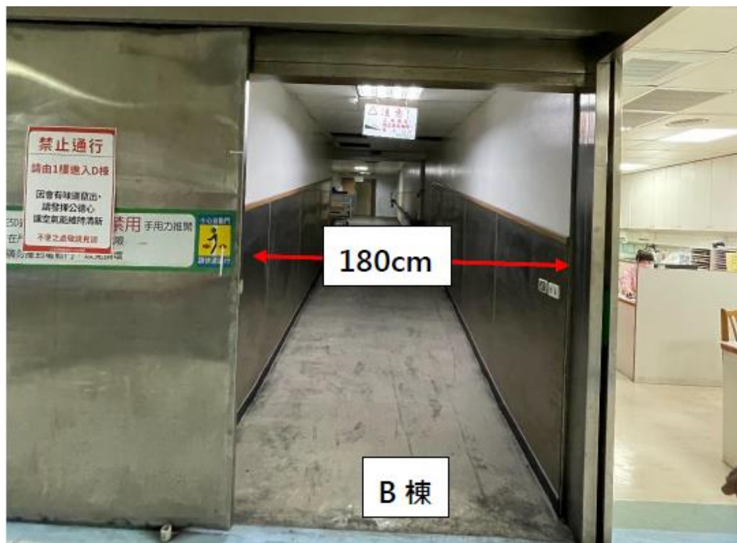
圖 15.5 樓連通道靠近 B 棟端出入口約僅 180 公分寬
