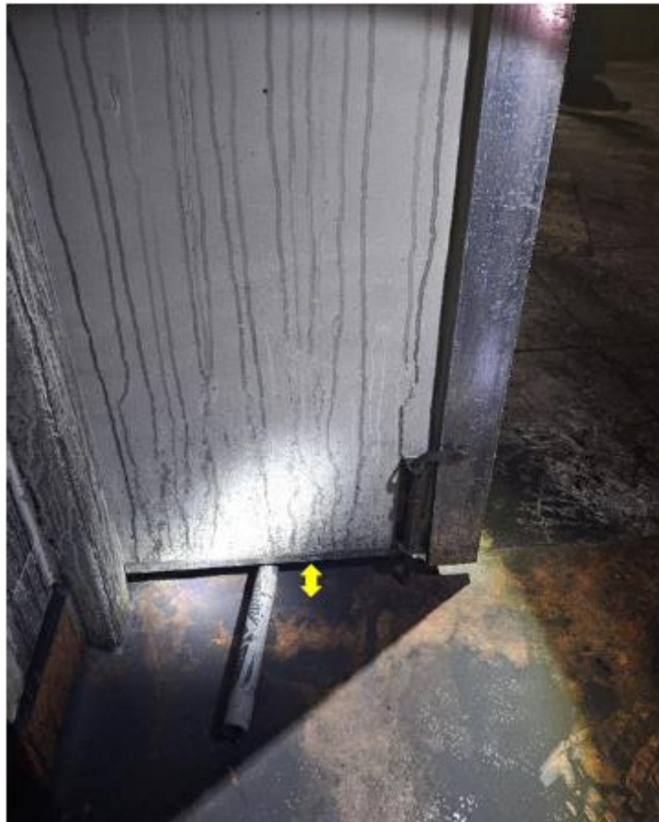
圖 21. D 棟安全梯防火門下方縫隙過大(黃色箭頭)
