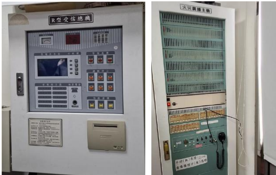
圖 23. 故障之受信總機螢幕（左）、火災廣播總機（右）位於警衛室
