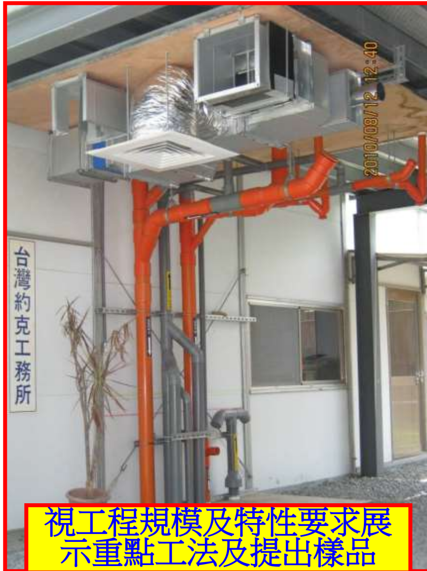
空調風管工程及污排水管 工法展示
