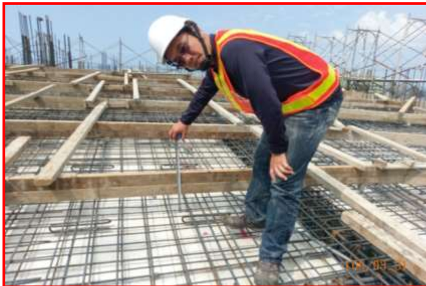
專任工程人員混凝土澆築前督察
