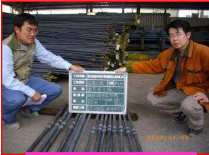
續接器鋼筋取樣
