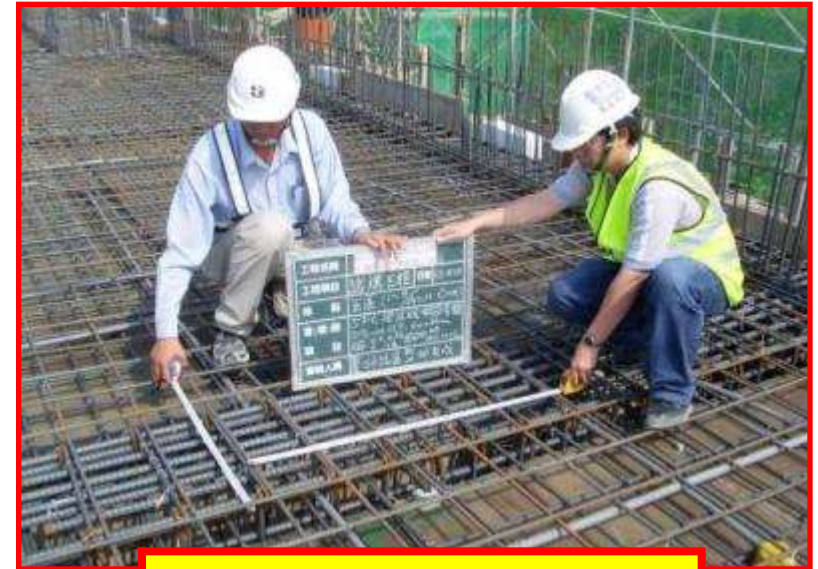
梁板鋼筋自主檢查
