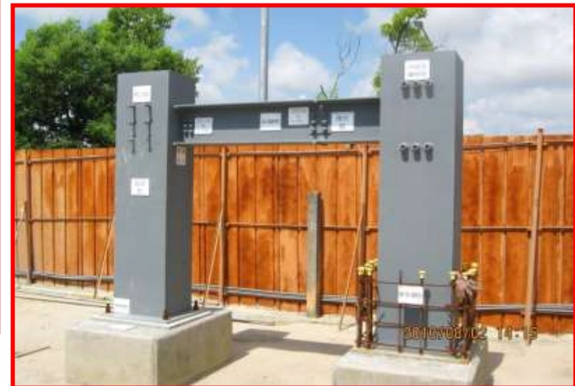
鋼結構施工工法展示
