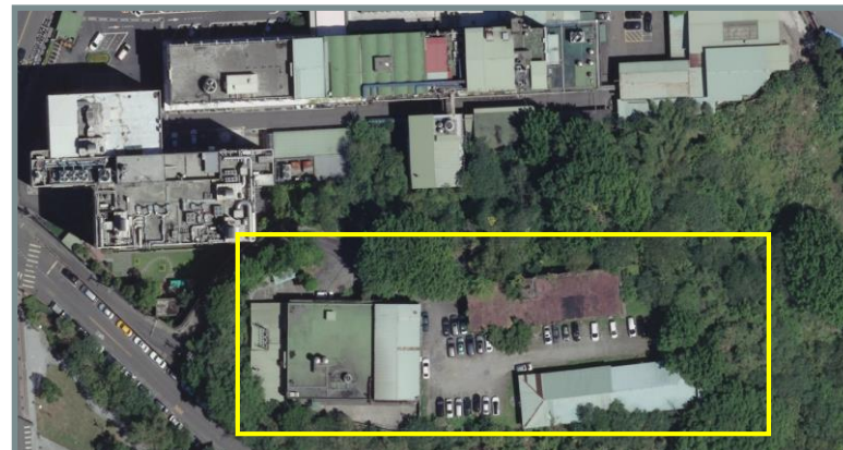
現代化食品藥物國家級實驗大樓暨行政及訓練大樓施工前
