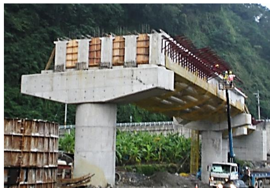
照片 10：預力梁吊放後隔梁施工中
