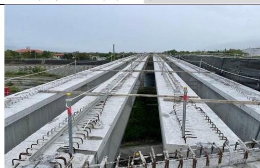
照片 8：吊放後-木料角材橫向連結
