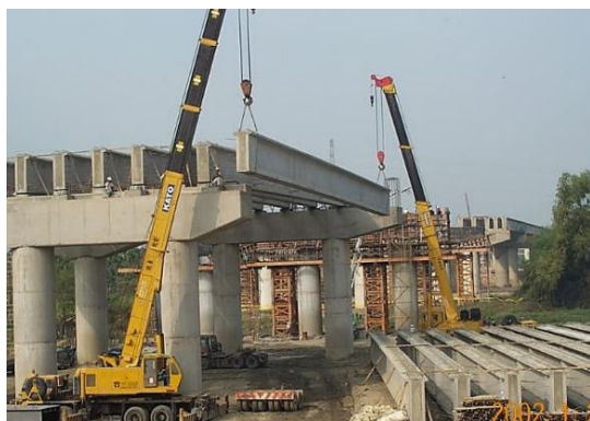
照片 9：預力梁之預鑄與吊放作業
