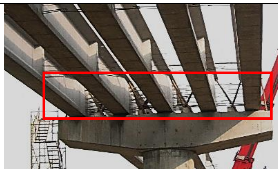
照片 6：吊放後-斜撐只於兩端帽梁
