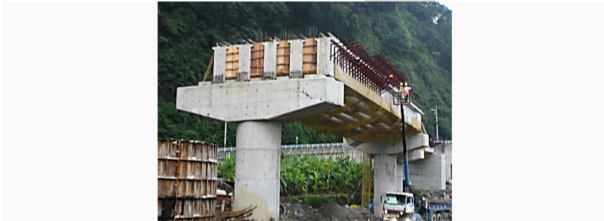
圖 8 端隔梁現場施工圖
