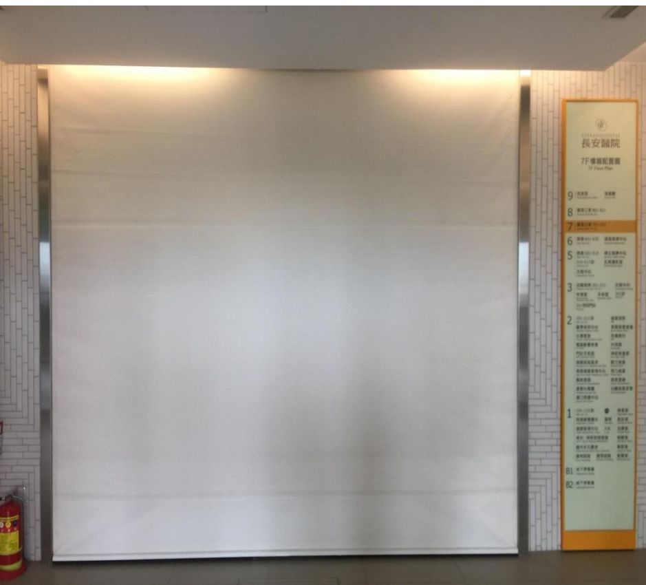
電梯貫穿垂直防火區劃處以遮煙捲簾遮蔽 (圖片來源：潘國雄老師研究室，2017.08.18)
