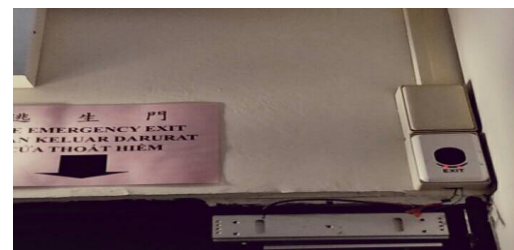
手動斷電系統
