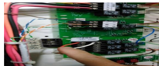
火警警報設備連動門禁自動解除裝置
