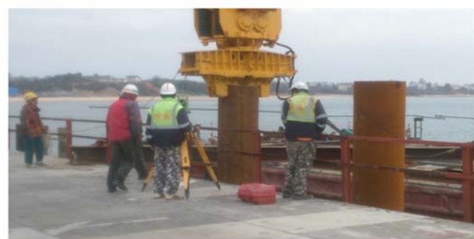
1050、120電動打樁錘+180T吊車
