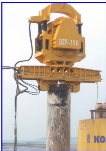
150電動打樁錘+150T吊車
