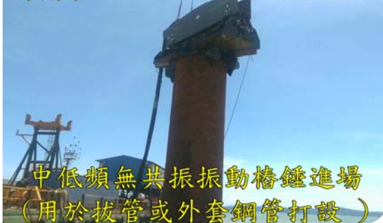
荷蘭製ICE250NF 振動樁錘
