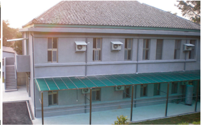
● 對於不願遷入新建醫療大樓的樂生院民，政府亦出資修繕房舍，以改善其居住環境。
