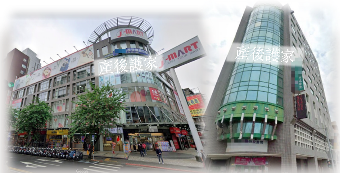
複合型 (商業大樓/醫院附設型) (大多設有自動撒水設備)
